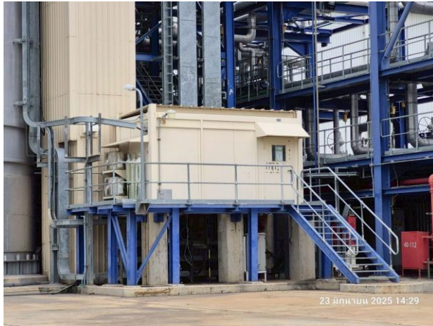
รูปที่ ข.2-1 ระบบตรวจสอบคุณภาพอากาศจากปล่องแบบต่อเนื่อง (CEMS)
